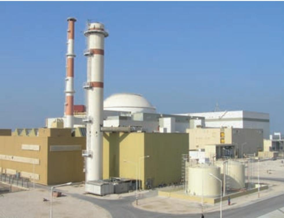
通常在灌注第一立方水泥的时候建设者们会进行一次庆祝，然而在布什尔建设者们庆祝的时刻却是为安装俄罗斯设备第一次从反应堆舱拆卸掉3500立方米的水泥。设备的尺寸与德国设计的参数不一致，反应堆装置更是完全不同，俄产蒸汽发生器是立式的，而Siemens所产的蒸汽发生器为卧式。
